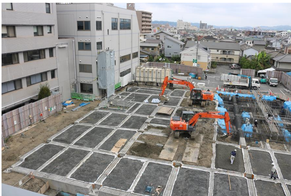
▲外来棟屋上(西側)から、新・リハビリ棟工事現場を望む。 【10月7日撮影】
