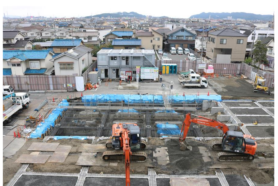
▲検査棟4階から、新・リハビリ棟工事現場を望む。 箕島方面。【10月7日撮影】
